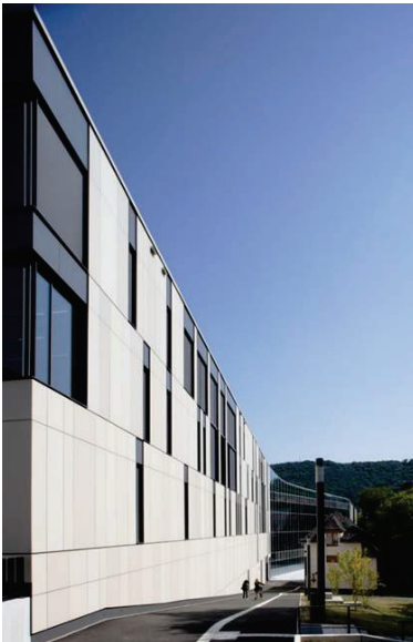
Abb. 3: Außenansicht Neubaukörper (Foto: THM Mittelhessen)
