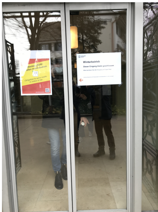
Abb. 10: Hinweistexte an der Schiebetür (von außen)
