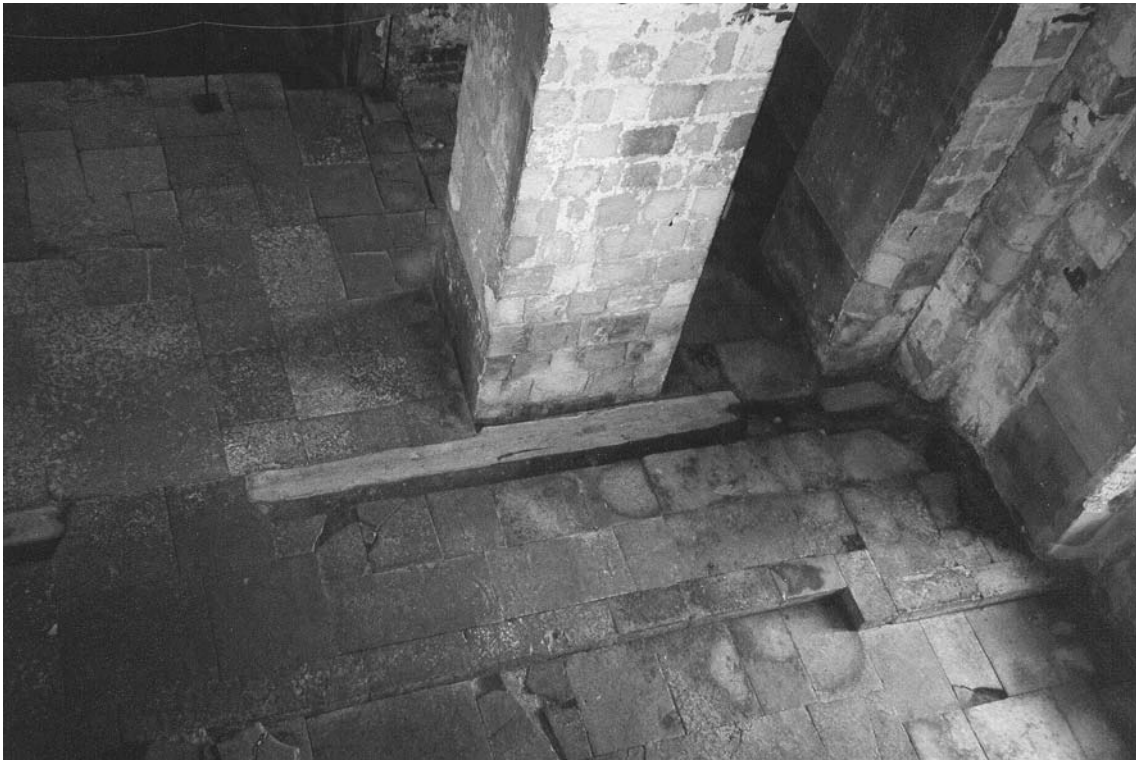
Abb.43 Innenraum: Südöstlicher „Pfeiler“, Fußboden.
