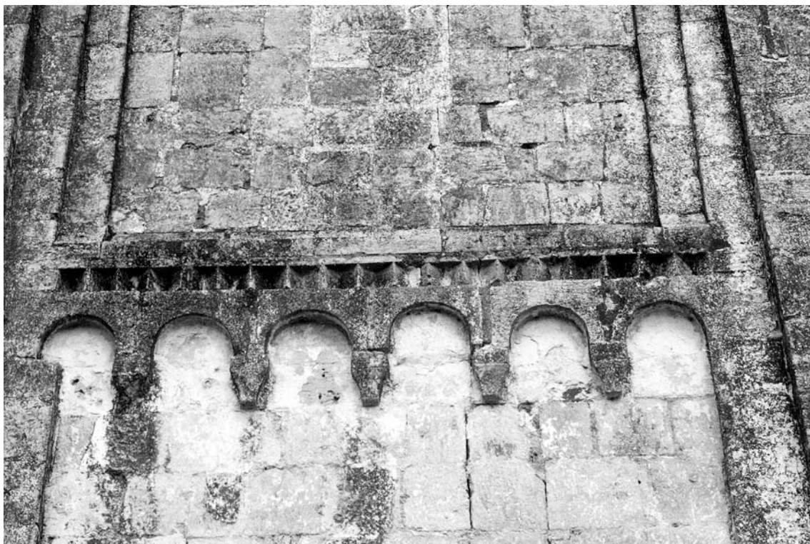
Abb.19 Südfassade. Fragment: der untere Teil des zugemauerten Fensters. Blendbogenfries.
