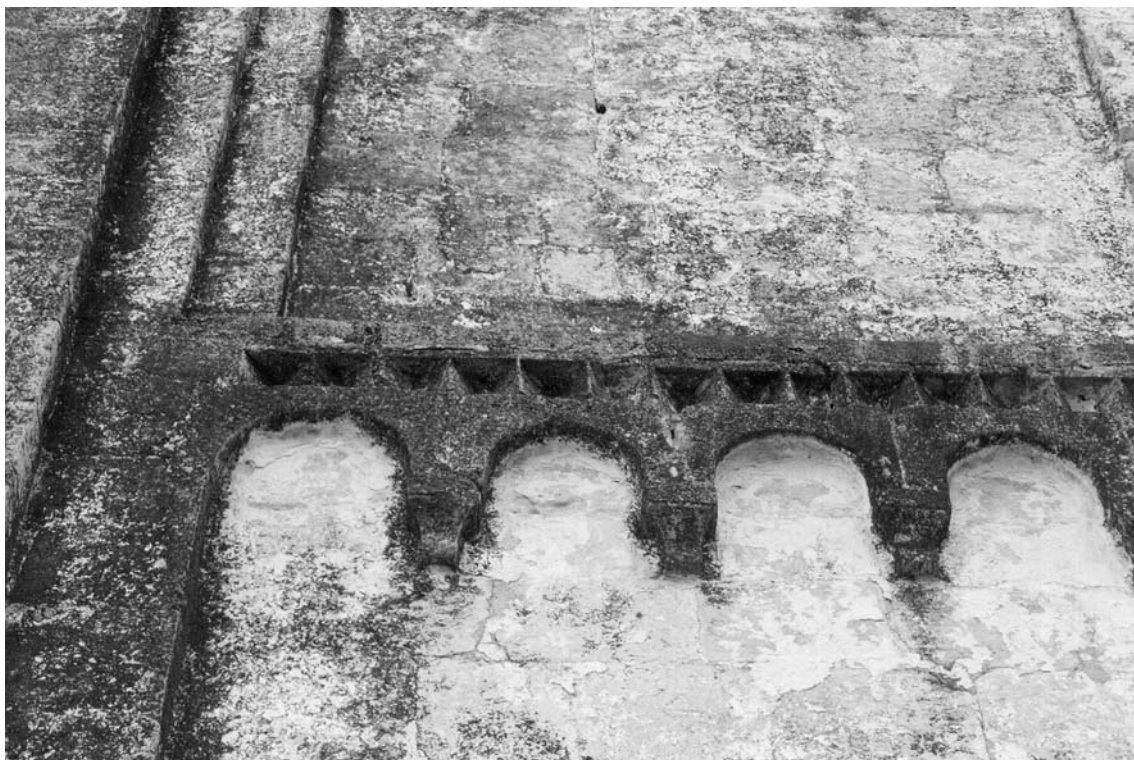
Abb.25 Westfassade. Fragment: Blendbogenfries
