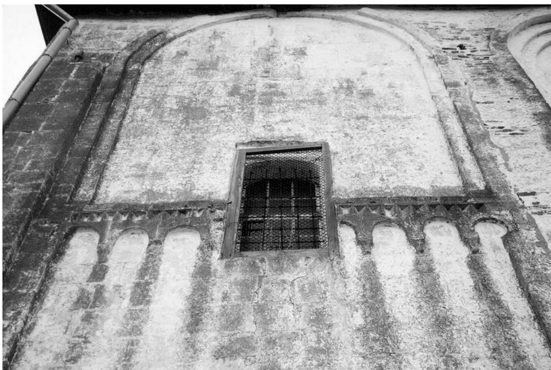
Abb.29 Nordfassade. Fragment: Fenster des 17. Jh.
