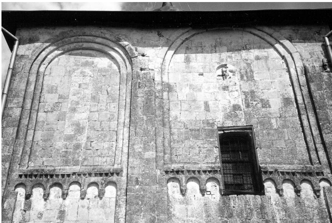
Abb.18 Südfassade. Fragment: Fenster des 17. Jh.
