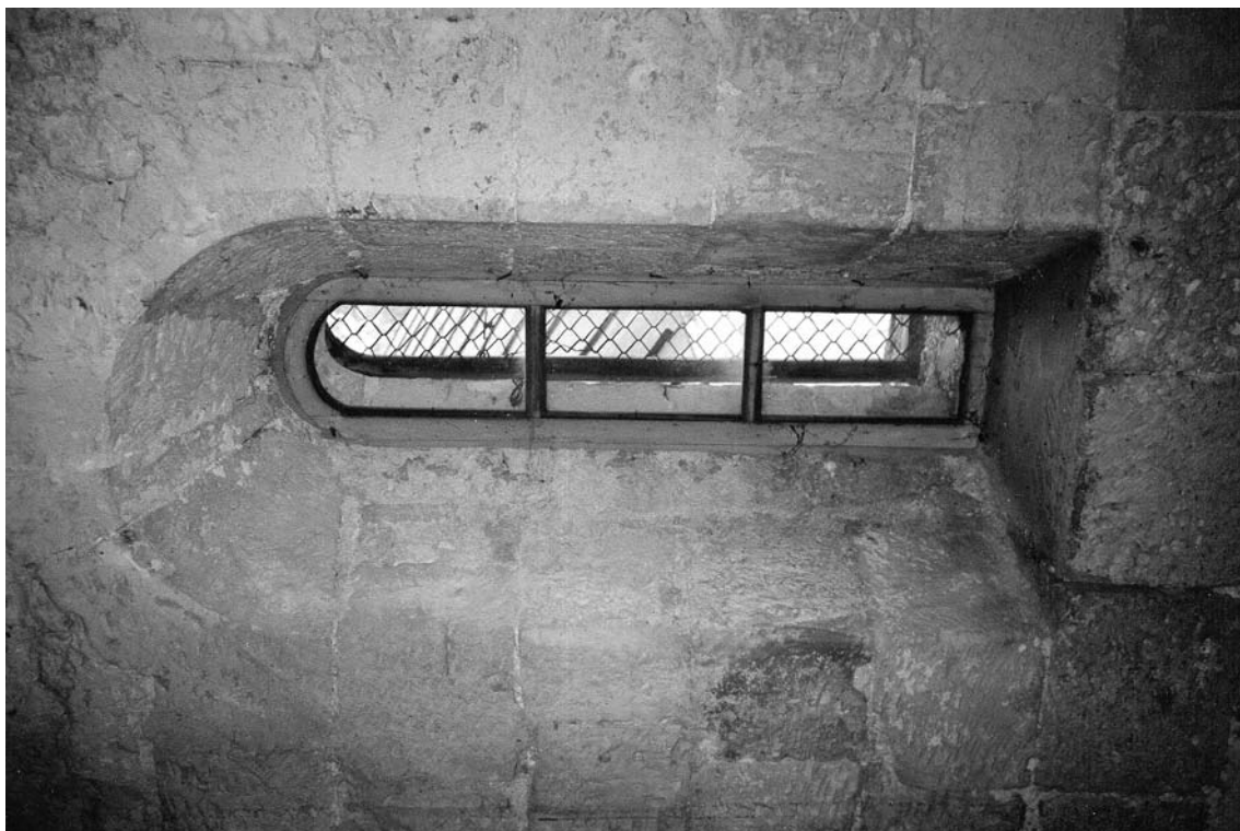
Abb.42 Innenraum: Fenster der Westfassade
