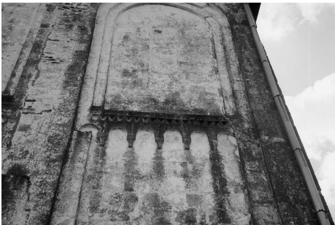
Abb.30 Nordfassade. Fragment: Blendbogenfries
