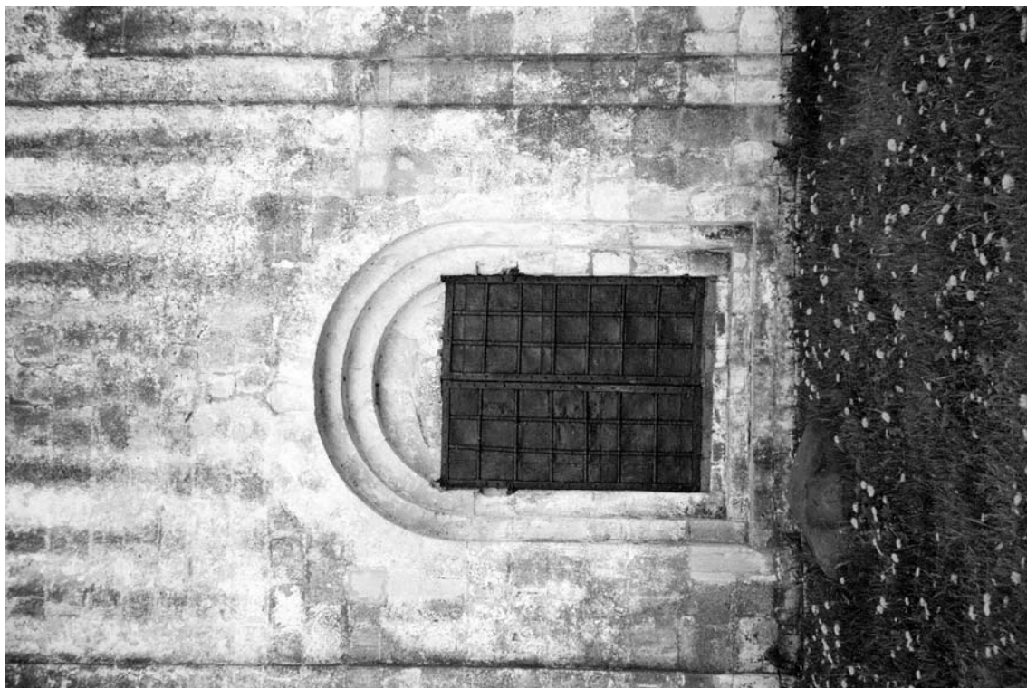
Abb.31 Nordfassade. Stufenportal, Tür.
