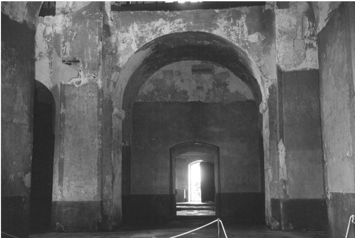
Abb.38 Innenraum: westliches Pfeilerpaar, Emporengewölbe.
