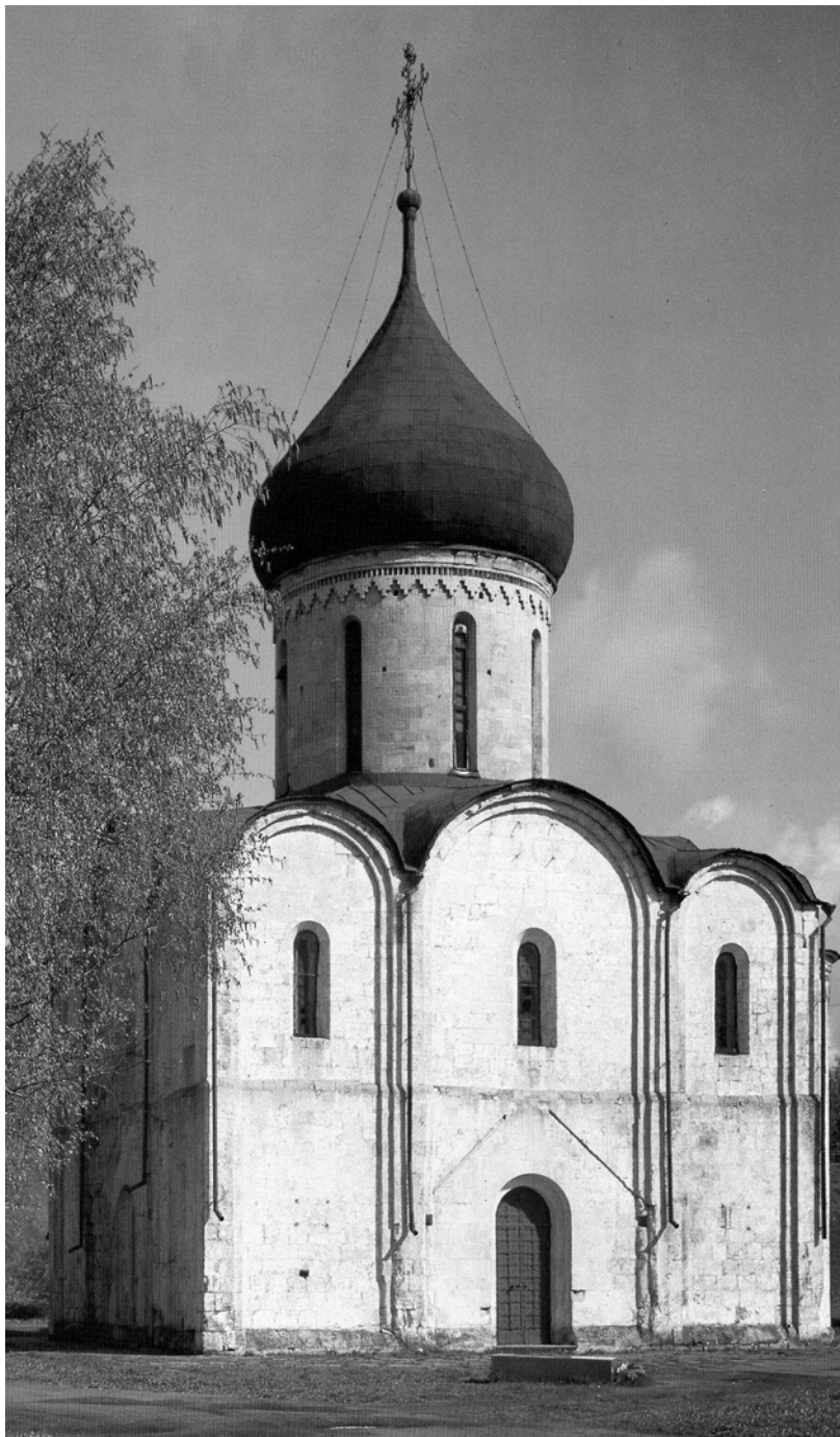
Abb.62 Verklärungskathedrale in Pereslawl Zalesskij. Westfassade
