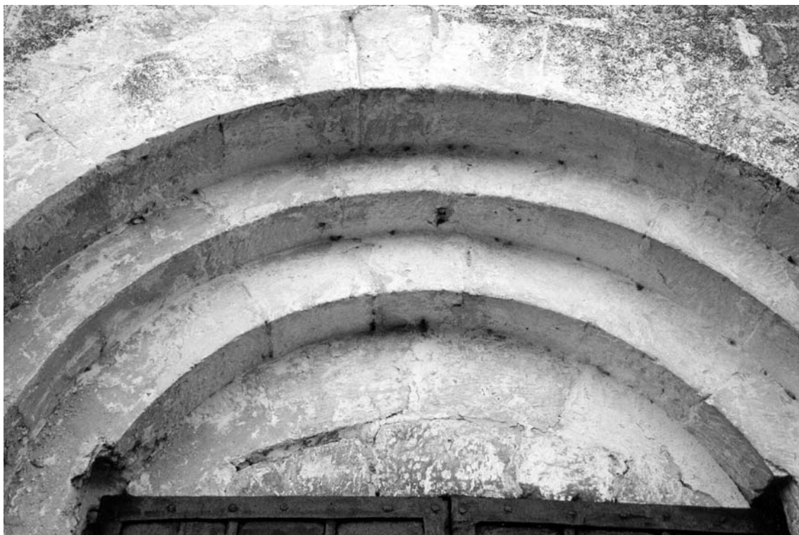
Abb.32 Nordfassade. Oberer Abschluss des Stufenportals
