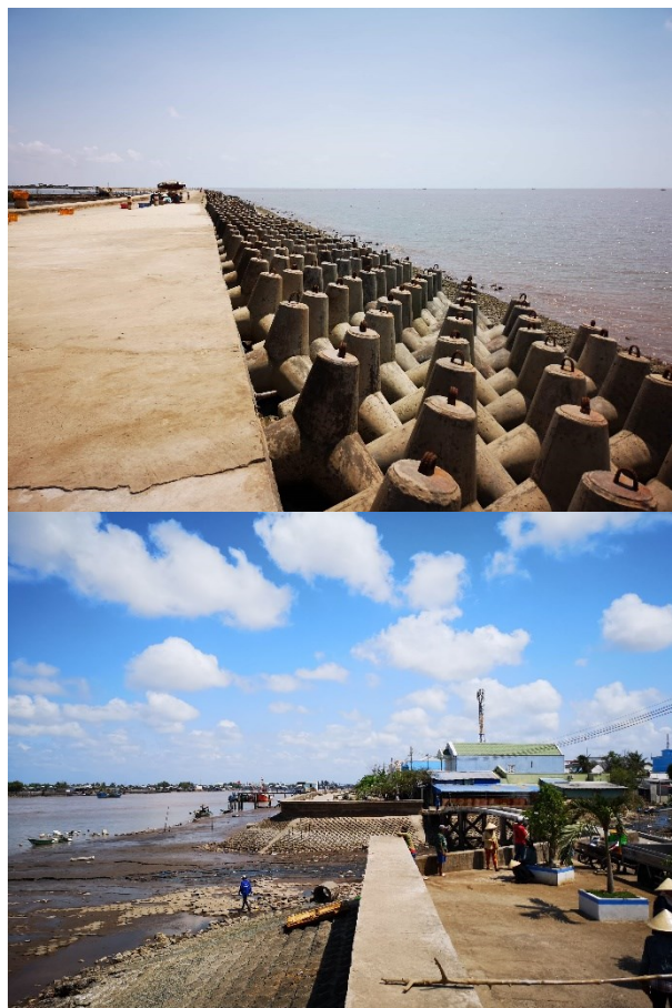
Fig. A.2 Sea walls in Ganh Hao, Bac Lieu province
