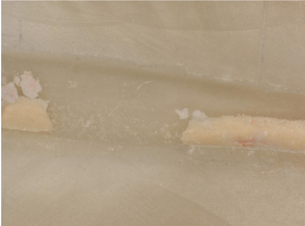
Abbildung 10: Beispielaufnahme eines Kanalabschnitts nach dem 1. Revisions-schritt in 200x Vergrößerung
