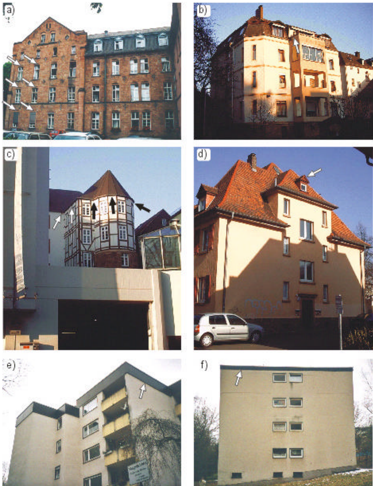
Abb. 22: Quartierspektrum Marburg. Quartiere a) in Fensterspalten an Sandsteinbau (a: ‚Psychologie Marburg‘), im Zwischendachbereich unter Schieferplatten eines Fachwerkturmes (c: ‚Turm‘) und unter Dachziegeln eines Wohnhauses (d), unter Zinkblechverkleidungen an einem Balkon (b) und im Dachabschlußbereich (e, f). WSQ: a-e. EQ: f. Pfeile kennzeichnen Ausflugsöffnungen der Quartiere.
