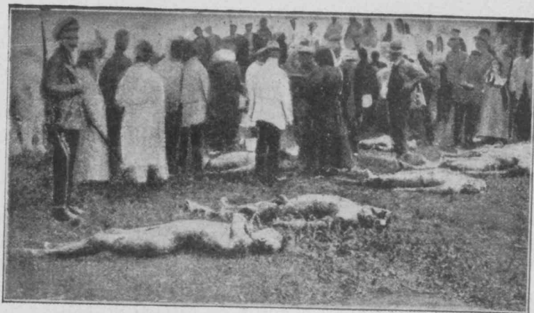
Charkow. Besichtigung der Opfer des Schreckenshauses an der Tschaitowstaja durch die Einwohner.
