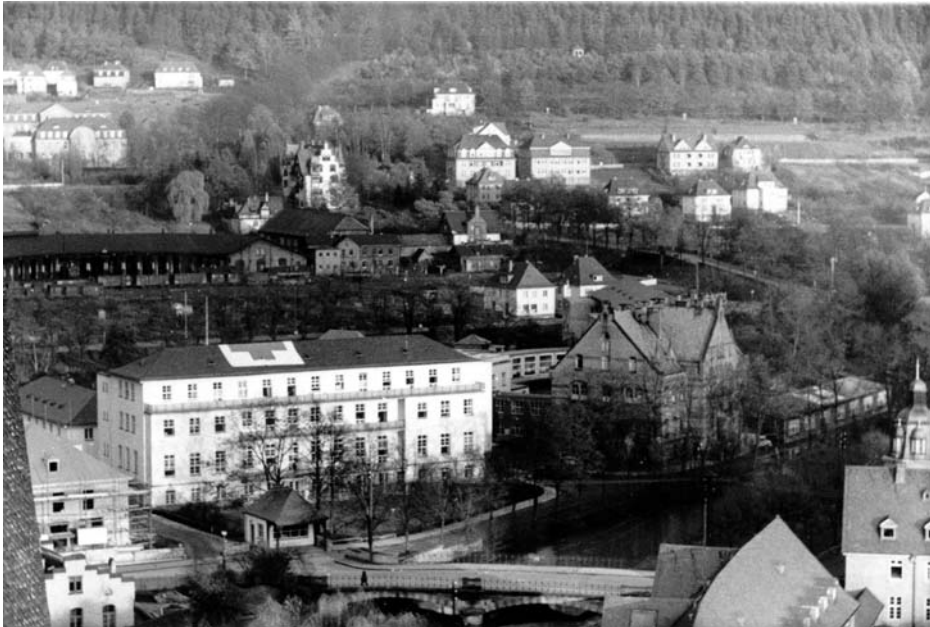
Abb. 5: Die Chirurgische Klinik nach der Bombardierung im Februar 1944 von der Uferstraße aus gesehen (Original: Frau Dr. R. Friess, Marburg)
