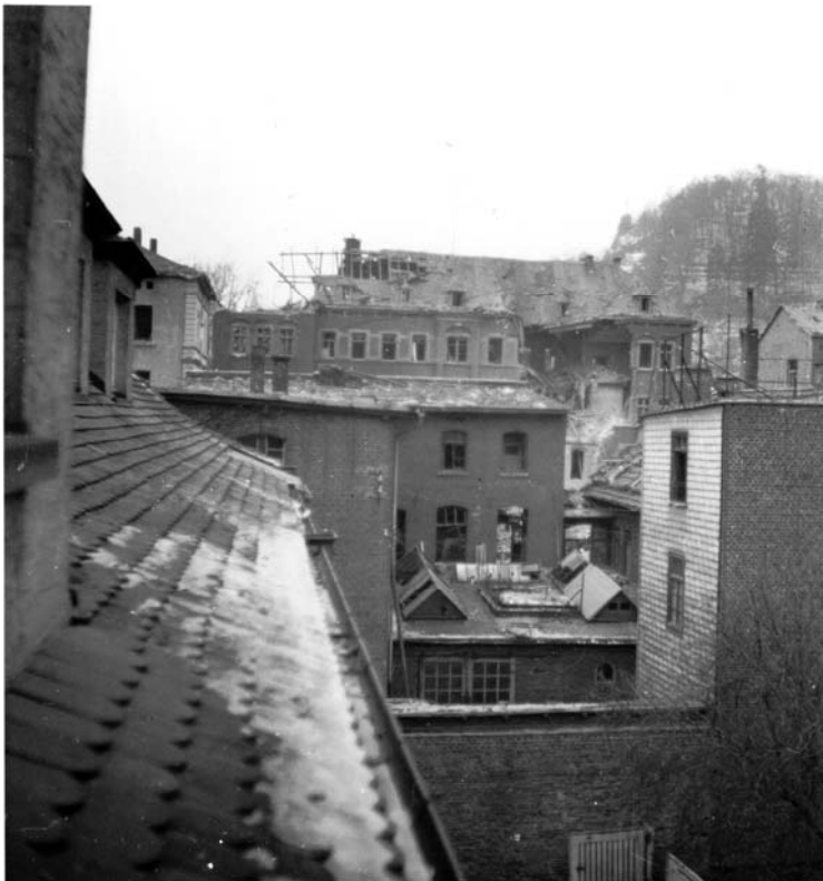
Abb. 6: Bombenschäden der Augenklinik (Emil von Behring-Bibliothek)
