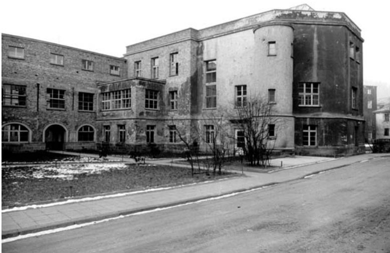
Abb. 8: Bombenschäden an der Chirurgischen Klinik 1946/47 (Bildarchiv Foto Marburg, Nr. LA 1.497/26a)
