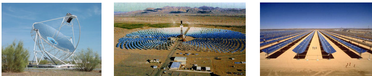
Abbildung 2.2: Dish-System (links, Eurodish auf der Plataforma Solar de Almería, Spanien, © Quaschnig 2003); Turmkraftwerk (mitte, Solar One in Barstow, Kalifornien) und Rinnenkraftwerk (rechts, SEGS in Kramer-Junction, Kalifornien, © KJCSOLAR, 2003).
